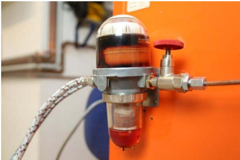
Zum Beispiel die in Brennstofffiltern von Heizöltanks verarbeiteten Polymere sind Untersuchungsgegenstand des Forschungsprojekts. Foto: IWO
