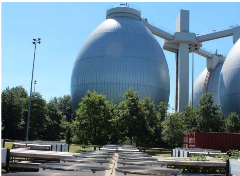
Fermenter in der Kläranlage Emschermündung. Foto: FiW
